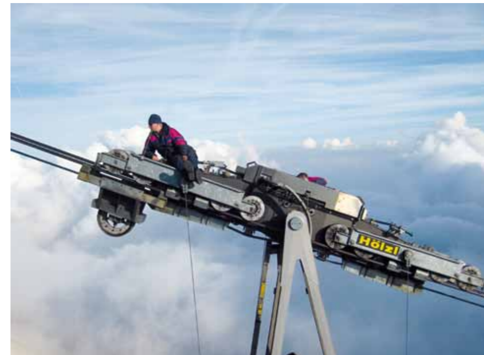
Revolution: Statt bei Kälte, Regen und Wind in schwindelnder Höhe wird die monatlich vorgeschriebene visuelle Seilkontrolle mit Winspect® von einem teilautomatisierten optischen Prüfgerät (Bild rechts) durchgeführt.
